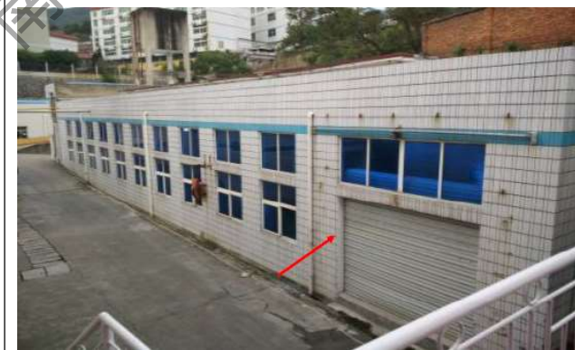
电镀车间废水处理设施
